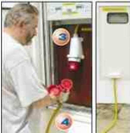
**3. Штеккер аварийного энергоснабжения** – точка подключения к источнику аварийного энергоснабжения
