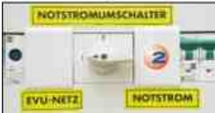
**2. Переключатель на аварийный источник энергоснабжения** – используется для безопасного переключения между основной сетью энергоснабжения и генератором. Таким образом отсутствует опасная передача электроэнергии обратно в сеть. Инструкция по эксплуатации находится на переключателе, короткая инструкция по эксплуатации находится на агрегате.
